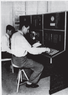
Abb. 2. Der Schaltapparat bei der Fertigung eines Rechenplans. Die Abtaster für den Lochstreifen sind deutlich sichtbar.
